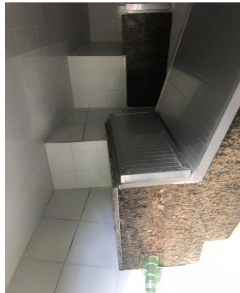
Caixa de Captação
