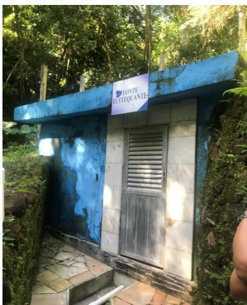
Casa de Proteção
