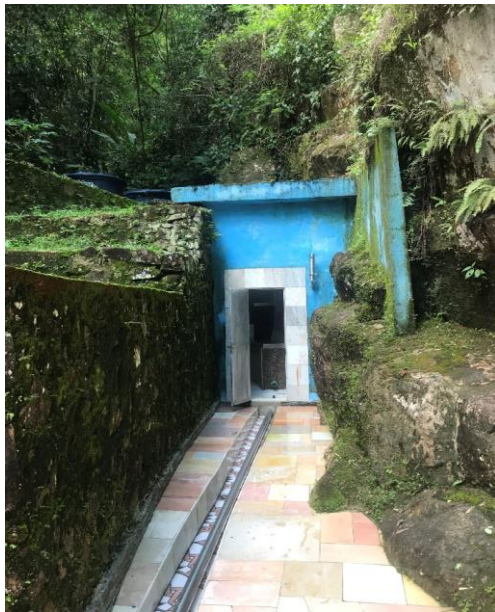
Casa de Proteção
